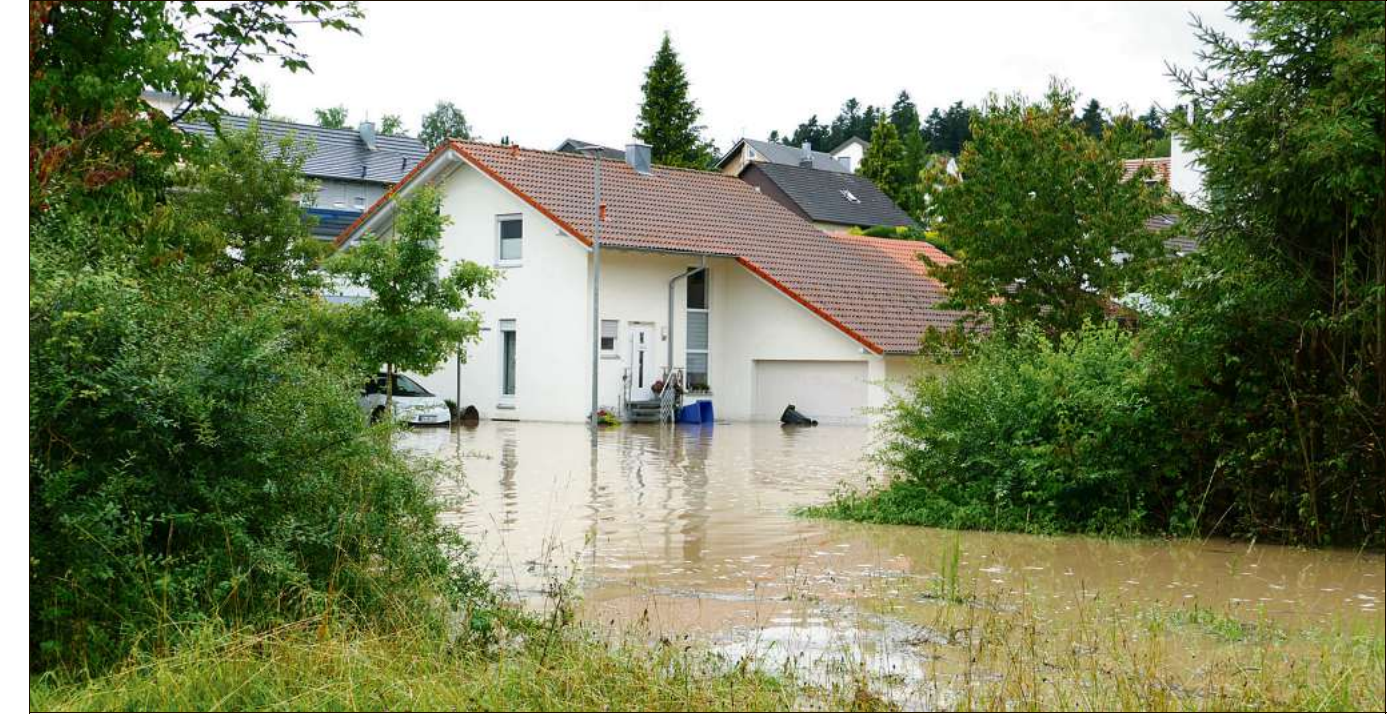
Das Wohngebäude in Bühlingen steht im Wasser, der Keller ist vollgelaufen.
