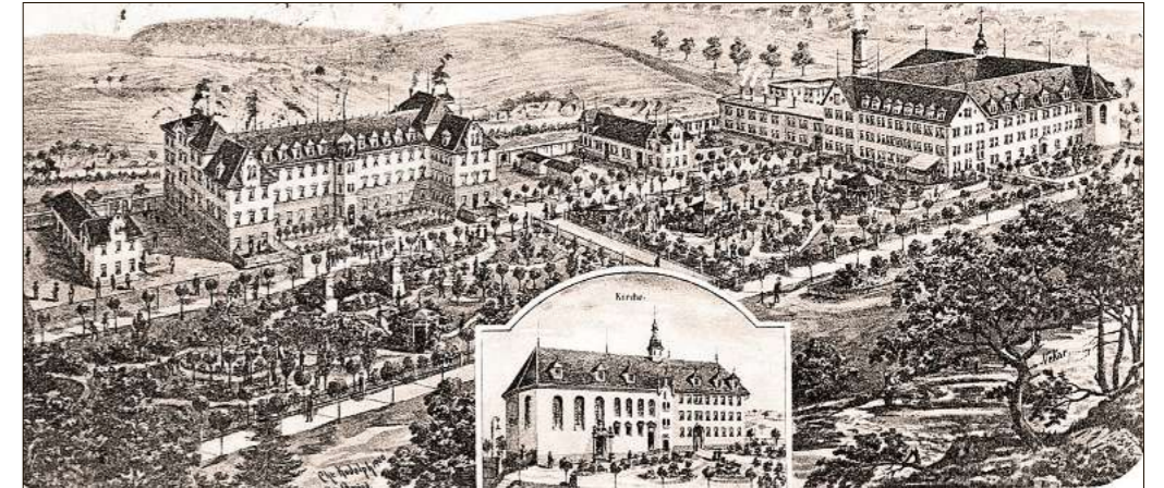
Rottenmünster war über Jahrhunderte für den Rottweiler Raum das Frauenkloster. Eine Postkarte von etwa 1900 zeigt rechts Baulichkeiten der Reichsabtei, links ergänzende Gebäude aus der Zeit der Vinzentinerinnen. Vorlage: Stadtarchiv Rottweil
