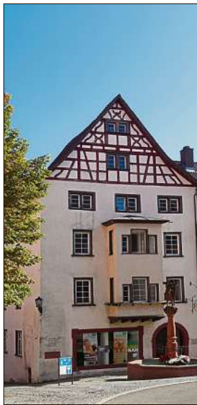
Das renovierte Gebäude am Friedrichsplatz 16 bietet Platz für 15 Bewohner des Psychiatrischen Rehabilitationsbereichs Vinzenz-von-Paul-Hospital. Fotos: VVP
